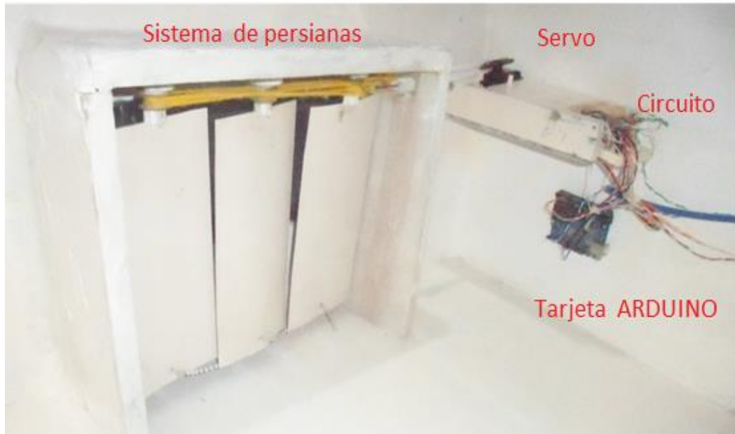
Figura 3.8 Interior de las casa habitación y montaje del circuito.
